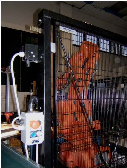
Fig. 3. Une des portes d'accès à la cellule robotisée: l'adaptateur Tina 2A rend tout interrupteur de sécurité à contacts mécaniques compatible avec le module électronique de sécurité Vital. (Photo: Jokab Safety)
