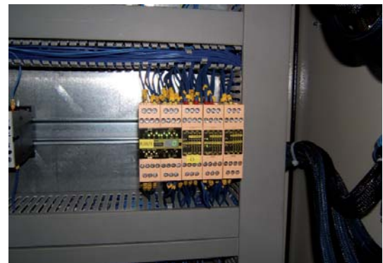
Fig. 5. Un seul API de sécurité Pluto S20 et trois relais d'extension EIT avec une multitude de sorties de sécurité forment le cœur de la commande logique de sécurité d'une cellule robotisée assez complexe. L'espace nécessaire dans l'armoire de commande est extrêmement réduit. (Photo: Jokab Safety)
