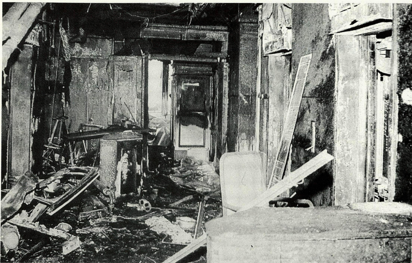
Incendie d'hôtel: six personnes ont perdu la vie dans ce local.
