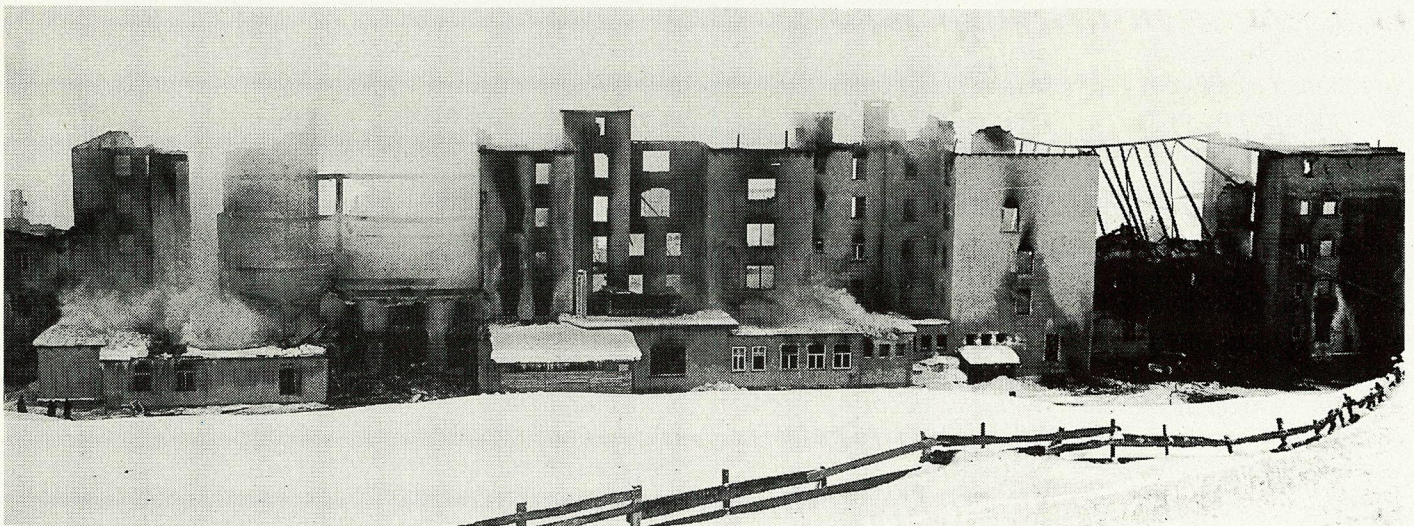
Même les hôtels plus anciens devraient disposer de deux voies d'évacuation indépendantes l'une de l'autre. Even the oldest hotels should have two totally separate escape routes.
